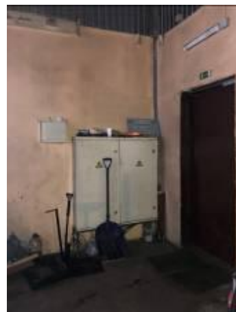
Inženierkomunikāciju pieslēgums ēkas 1.stāva līmenī
