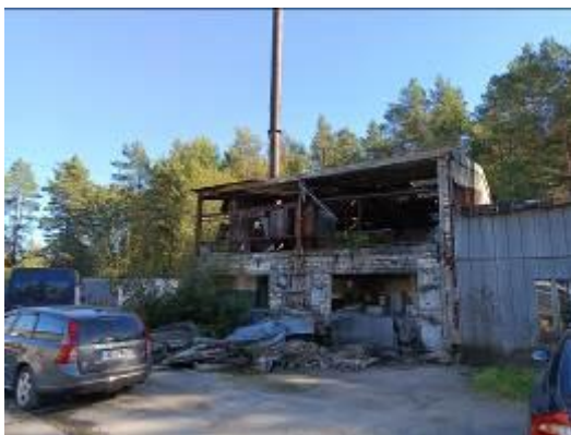
Skats uz katlu ēku.
